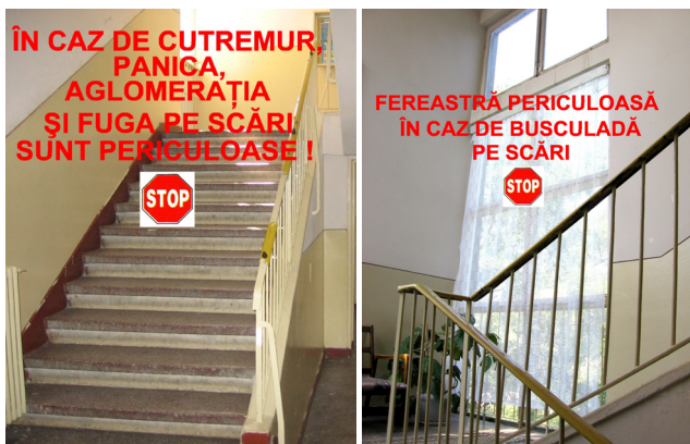
Fig. 9. Scările pot prezenta pericol de busculadă, alunecare, ciocnire cu ferestrele, tăiere și cădere în gol dacă sunt aglomerate cu elevi în timpul mișcării seismice
